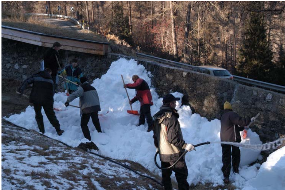
Der „Spatenstich“ erfolgte Ausgangs Sunny Corner
